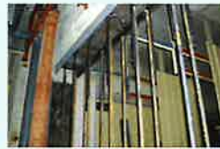
アンカー筋は接着なので低騒音・低振動
