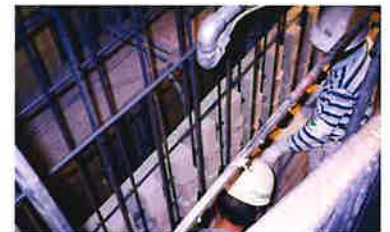
設備機器に挟まれた狭隘な施工
