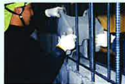
ブロックを積むだけなので低騒音・低振動
