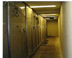
廊下片側に設けた仮囲いでの施工
