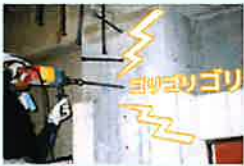
アンカー打設
